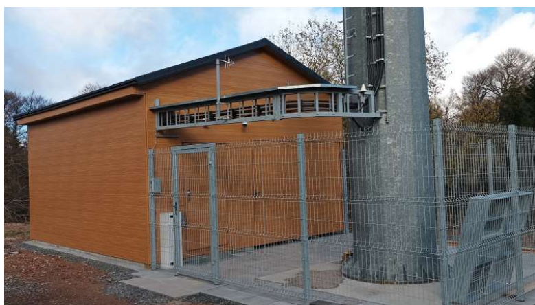
Nový DAB+ vysílač Domažlice - Čerchov - kontejner pro technologie
